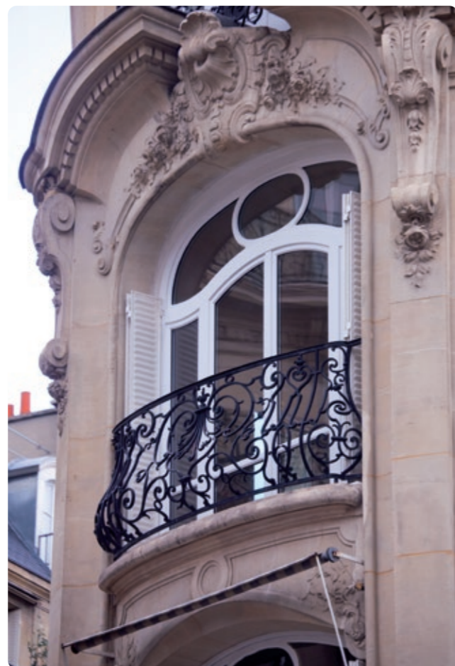
Porte fenêtre Tradilou avec imposte anse de panier et traverses chapeau de gendarme
