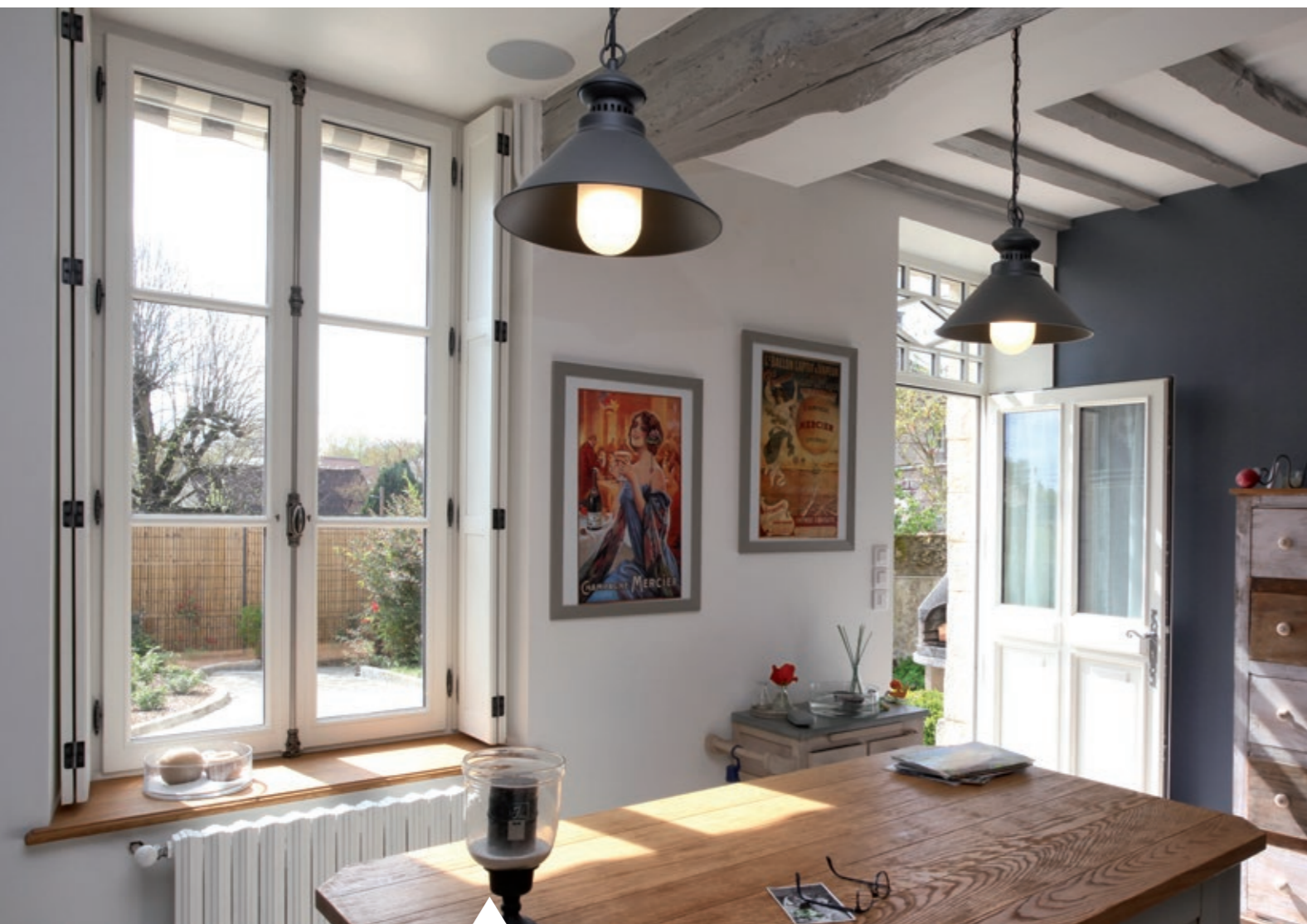
Fenêtre Estilou Finition peinture blanche RAL 9016 Parcloses à doucine Crémone véritable et fiches turlupet vieil argent
